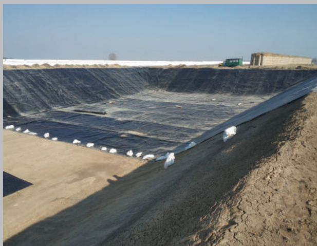
Гноєсховища з плівки (з використанням мембран HDPE) відкритого та закритого типу
