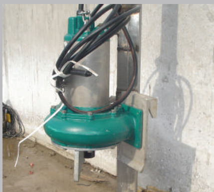
Занурювальний насос з системою швидкого з'єднання на монтажній шині. Насоси можуть бути змонтовані не тільки в нових збірник, а і в збірник, що використовується
